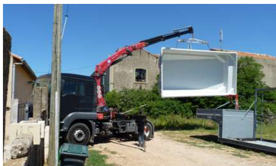
LIVRAISON DE LA PISCINE
