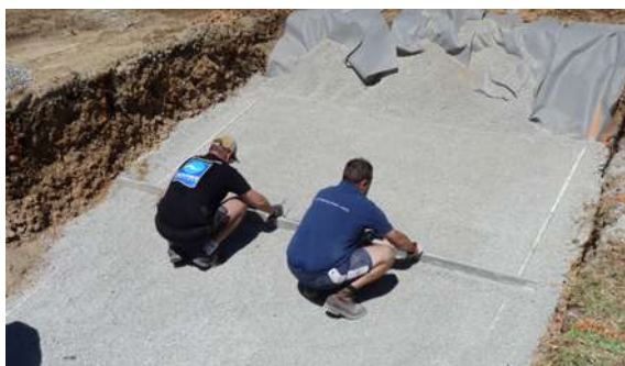
PRÉPARATION ASSISE DRAINANTE
