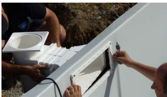
MISE EN PLACE DES PIÈCES À SCELLER
